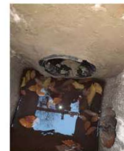
SISTEMA DI CADITOIE STRADALI CON COLLEGAMENTO IN FOGNATURA E SOGLIA DI SFIORO VERSO AREE VERDI
