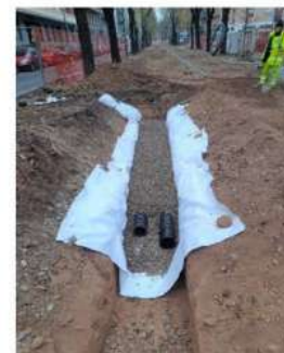
POSA DELLE TUBAZIONI DRENANTI
