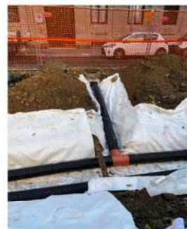
COLLEGAMENTO TRA POZZETTI E BACINI DRENANTI
