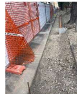
SISTEMA DI CADITOIE STRADALI CON COLLEGAMENTO IN FOGNATURA E SOGLIA DI SFIORO VERSO AREE VERDI
